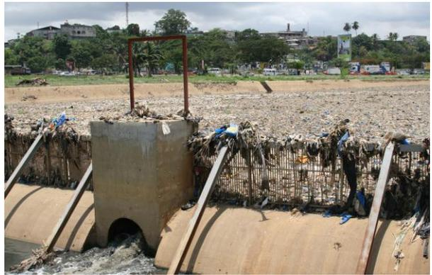
Conséquence directe du rejet par les ménages des eaux usées dans les canaux de drainage (photo de gauche) : les bassins de rétention sont saturés d'eaux grises (photo de droite), l'efficacité des installations est remise en cause et ne permet plus de prévenir les inondations en cas de forte pluie.
