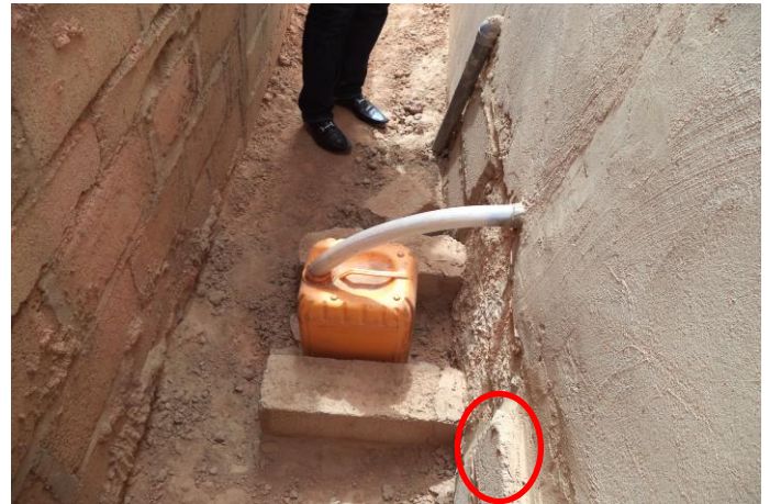
Récupération des urines dans un bidon et la partie encadrée en rouge est l'endroit à enlever pour récupérer les boues au moment de la vidange
