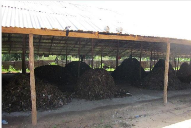
Andains sous le hangar sur le site de compostage de Lomé
