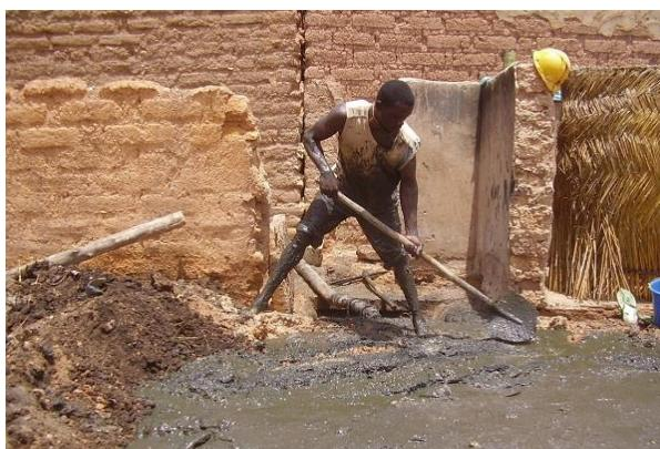
Lorsque ces ouvrages sont pleins, les ménages font appel soit à des vidangeurs mécaniques, soit à des vidangeurs manuels. Or, dans beaucoup de quartiers de Ouagadougou, les camions des vidangeurs mécaniques ne peuvent pas circuler par manque d'espace au vue de la densité du bâti. Par ailleurs, les boues séchées contenues dans les latrines ou les fosses septiques sont parfois trop solidifiées et nécessitent un traitement manuel. La vidange manuelle devient alors indispensable.
