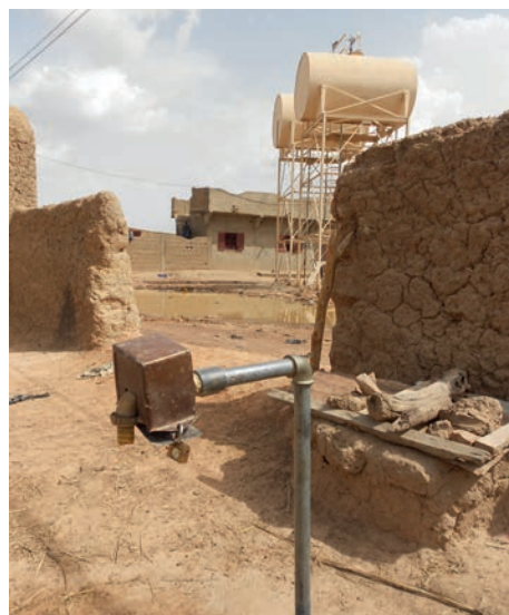
Point d'eau avec cadenas, situé dans une concession au Mali
