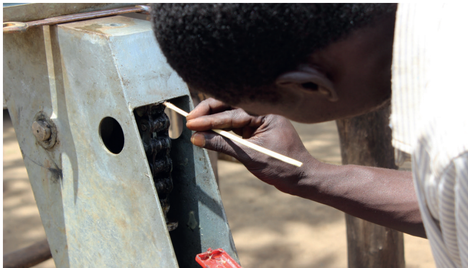
Maintenance d'une PMH en Ouganda
