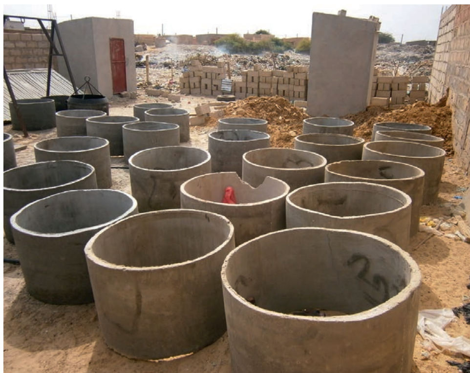
Construction de latrines en Mauritanie
