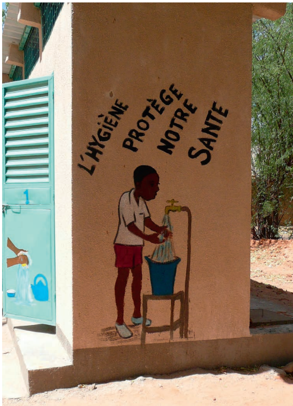
Latrine scolaire à Tessaoua, Niger.
