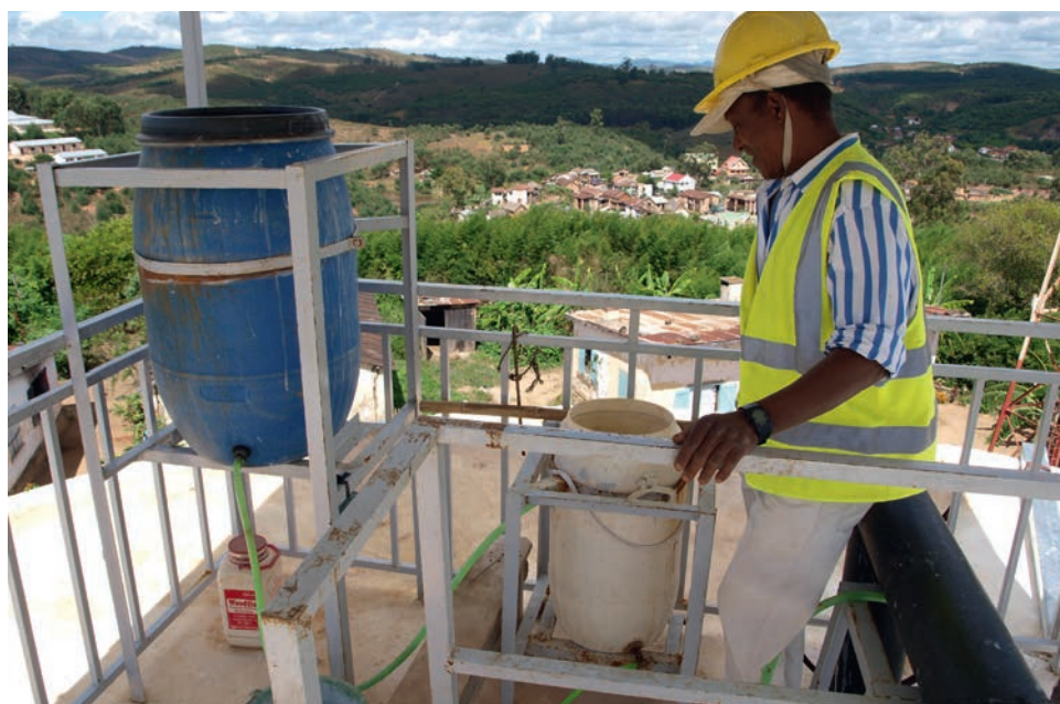
Chloration d'un réservoir d'eau potable à Madagascar
