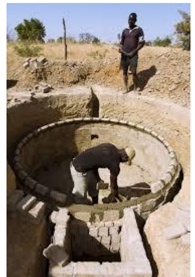
Construction d'un bio-digesteur
