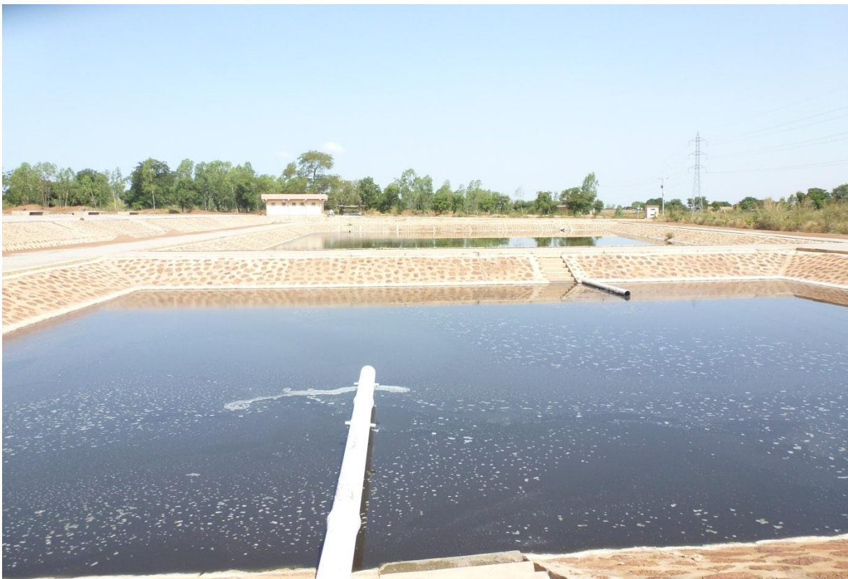
Bassins de traitement de la station
