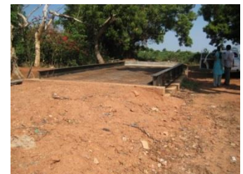
Pont bascule en entrée de la décharge
