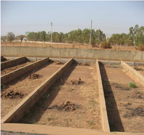
*Des casiers étaient initialement prévus au niveau de la station pour déposer les boues de vidanges mais ils ne sont pas fonctionnels : ils sont sous-dimensionnés et il manque de débouchés aux environs de la station pour utiliser les boues hygiénisées.*
